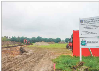
Erschließungsarbeiten in „Lammers Kamp“.
