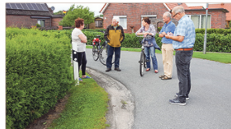
Stark abgesenkter Fahrbahnrand in einem Kurvenabschnitt.
