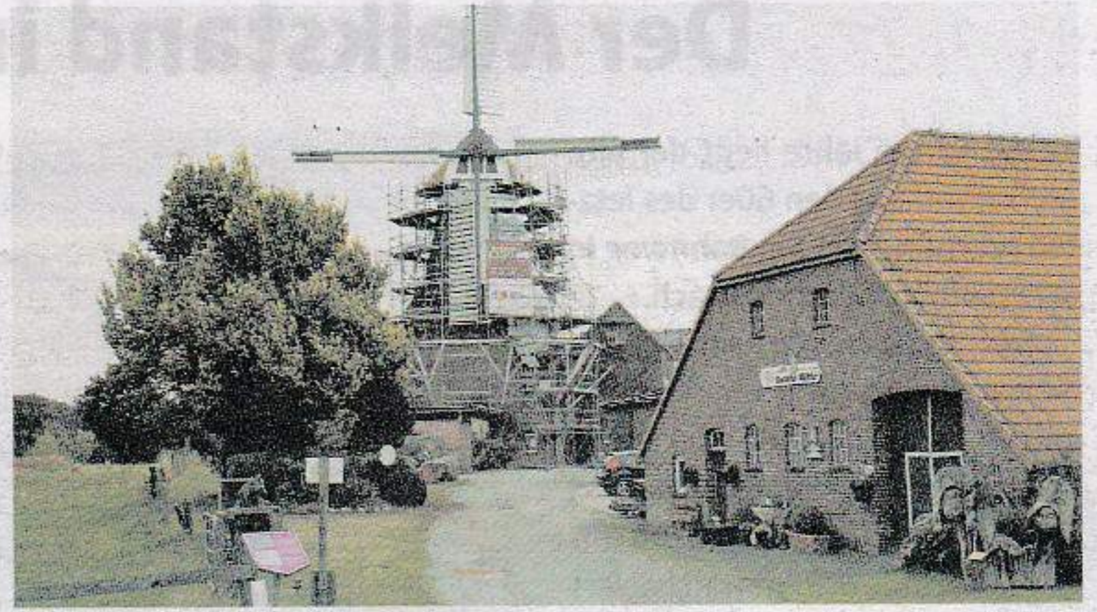
Sanierungsarbeiten der Rutteler Mühle.
