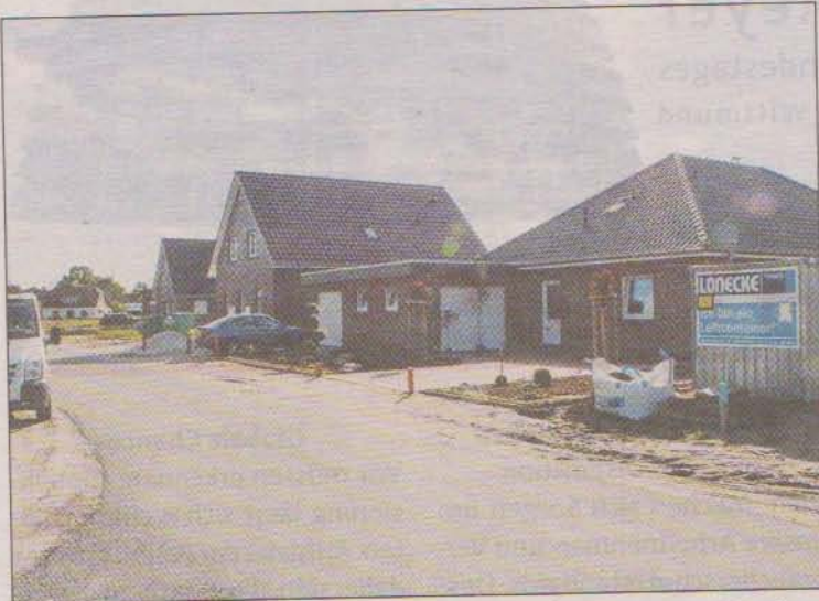
Das Baugebiet Bohlenberge auf dem alten Sportplatz zwischen der Wehdestraße und dem Schulweg.
