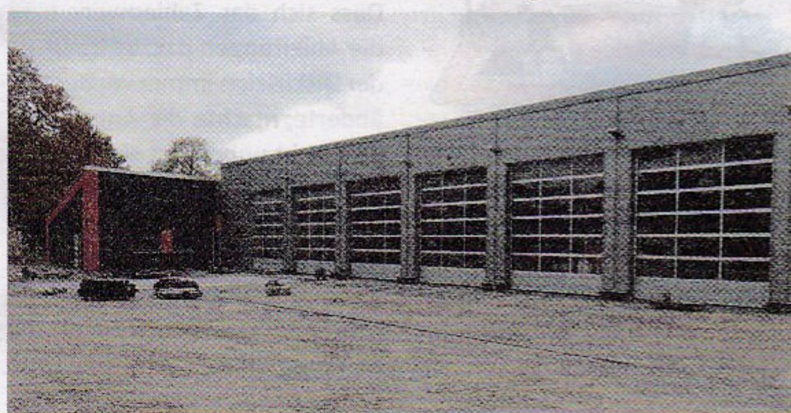
Das neue Feuerwehrgerätehaus ist fast bezugsfertig.
